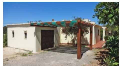
Casa B - Carport
